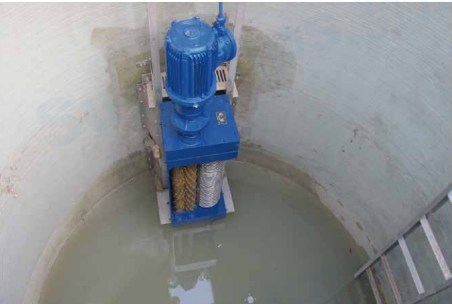
粉碎格栅在预制泵站中的安装实景
